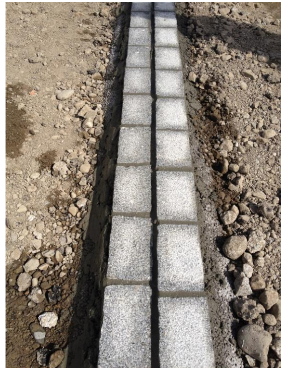
Gereinigte Randabschlüsse im Detail
