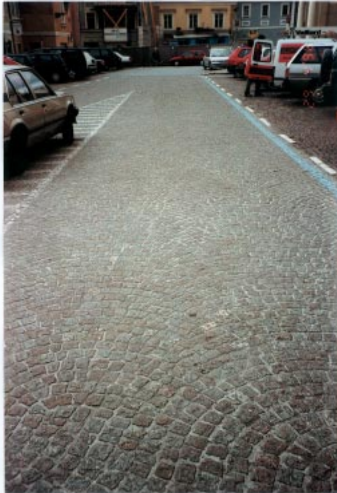
Gesamtübersicht der mit SAMCO 88 und SAMCO SAN sanierte Fläche.
