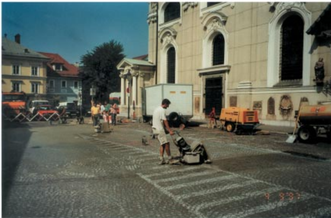
Vor- und Nachreinigung der bisher verwendeten Fugenschlämme.
