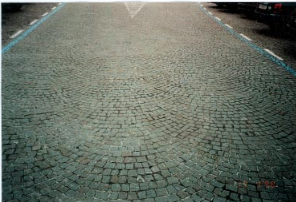
Gesamtübersicht der mit herkömmlichem Fugenmörtel sanierte Fläche.
