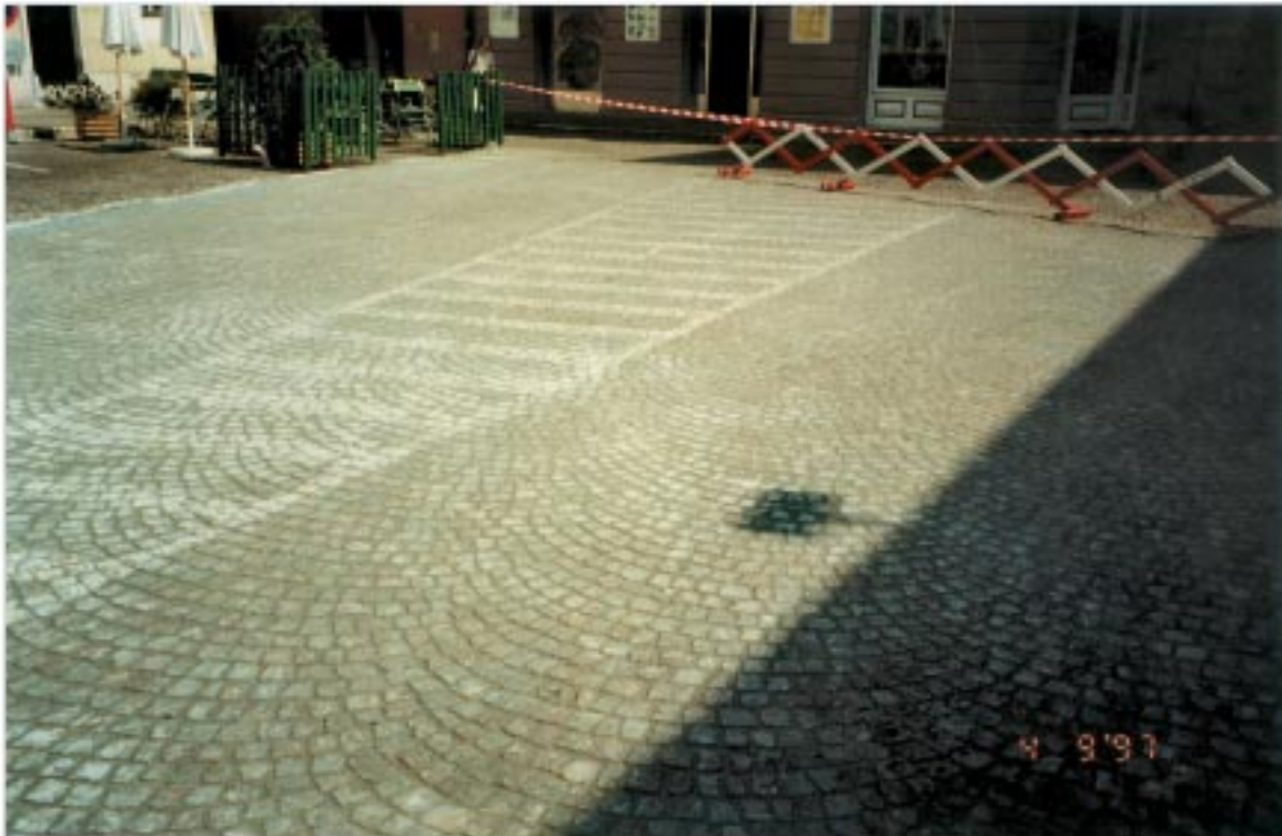
Fertig gereinigte Fläche mit SAMCO 88 und SAMCO SAN nach dem Ammann & Coduri Verfahren.
