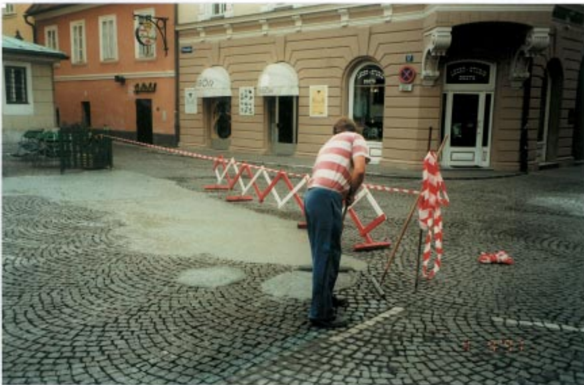
Beginn der Verfugung mit SAMCO 88 und SAMCO SAN – ca. 8. 00 Uhr.
