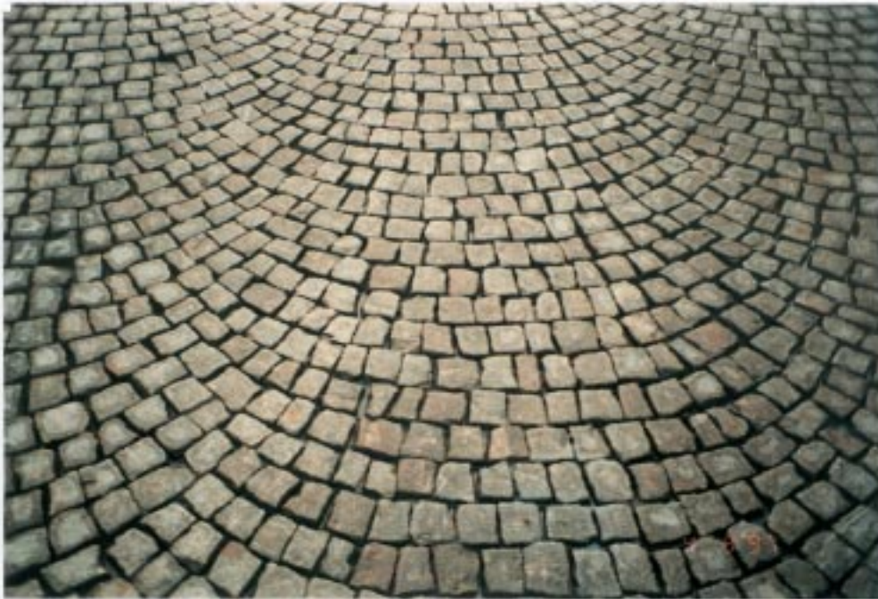
Die Pflasterfläche im Detail.
